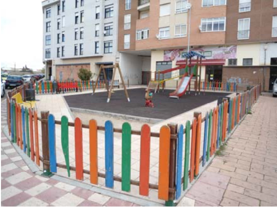
ESTADO DEL ARENERO Y VALLA DEL RECINTO.
